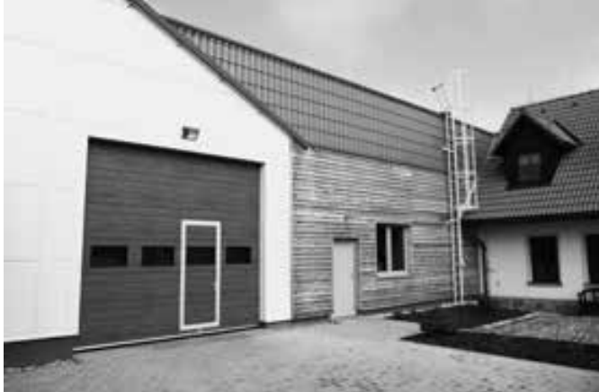
Výrobní hala firmy Design Weld s.r.o. Rohoznice
