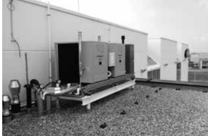
Skladovací hala Hagleitner Hygiene Slovensko, s.r.o. Senec
